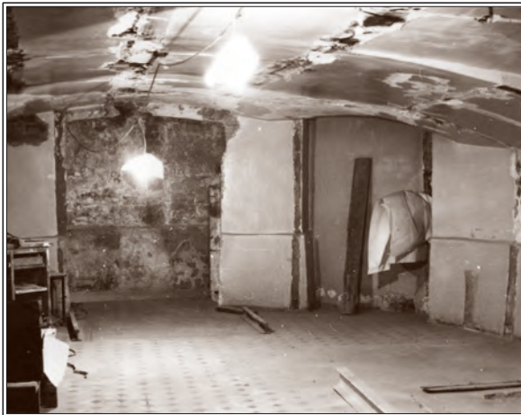
Алтарная часть храма-усыпальницы в здании Иоанновского монастыря в период восстановительных работ.
