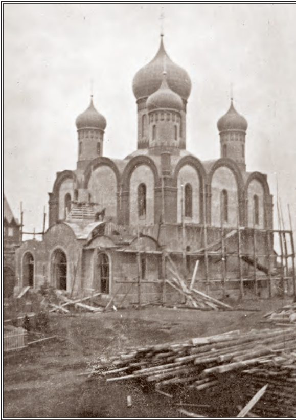
Строительство монастырского собора. 1909
