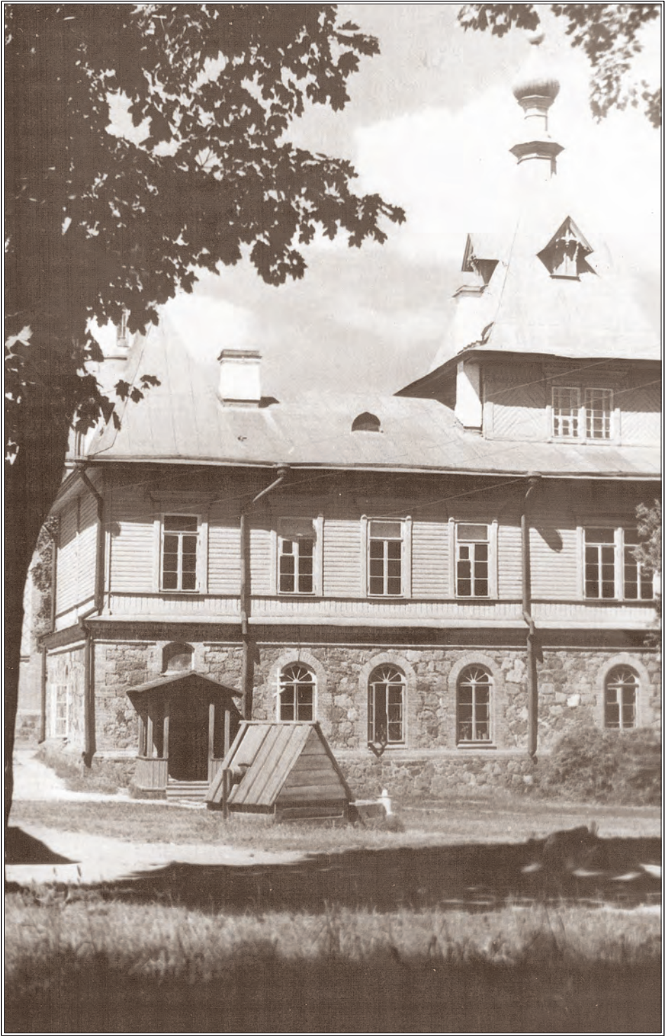
Трапезная церковь, построенная в 1895 году
