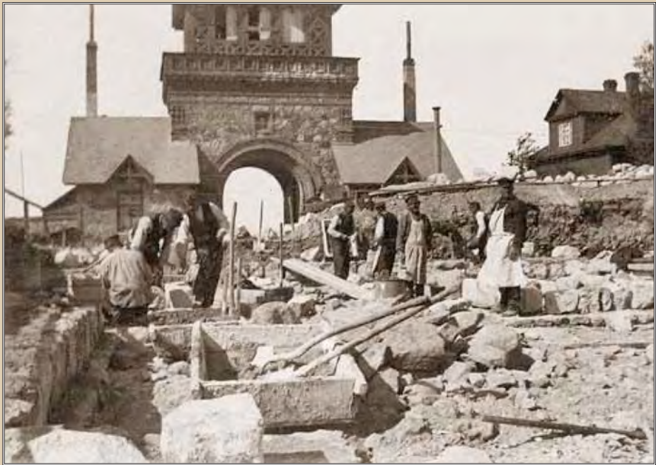
Строительные работы по укладке фундамента Пюхтицкого Успенского собора. 1908
